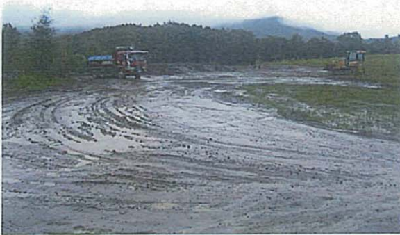
汚泥投入指定場所
