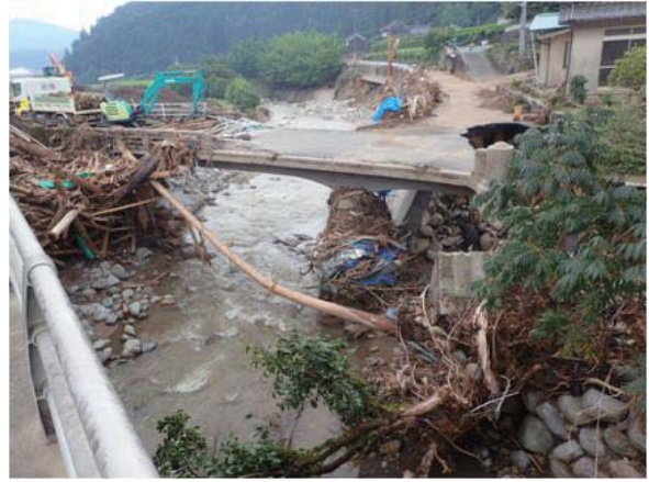
橋脚に引っかかった流木と 損壊した橋
