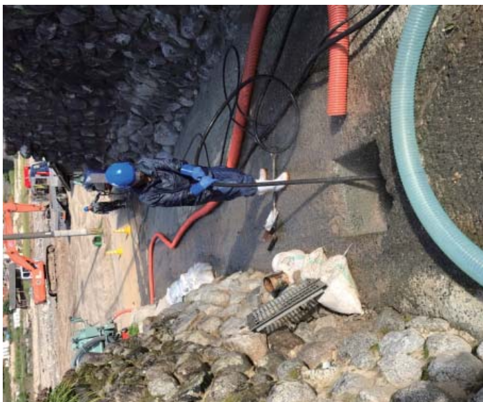
平成 29 年 9 月 30 日 朝倉市志波地区
