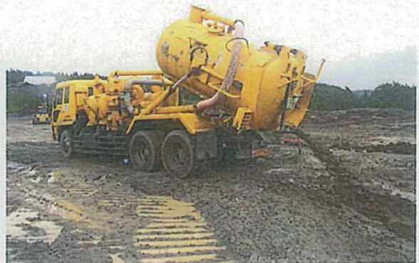
汚泥投入状況
