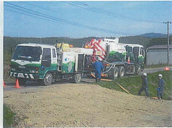
横断管清掃・鶴川衛生社
