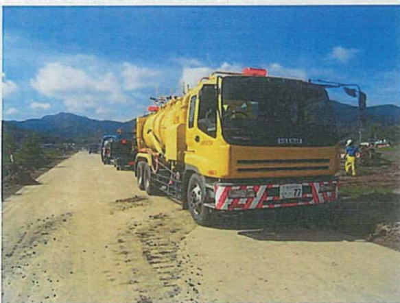
横断管洗浄・西塚ダンパー・増毛洗浄車・旭川浄化給水車
