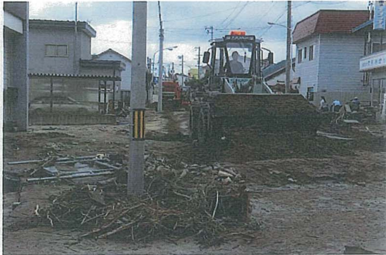
新得町内復旧作業
