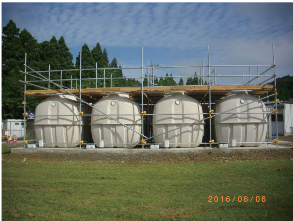
② 応急仮設住宅（益城町 津村グランド団地）
