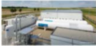
↓水電解プラント
