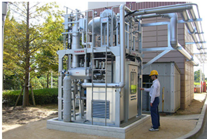
図 5-2-3 二酸化炭素回収試験設備
