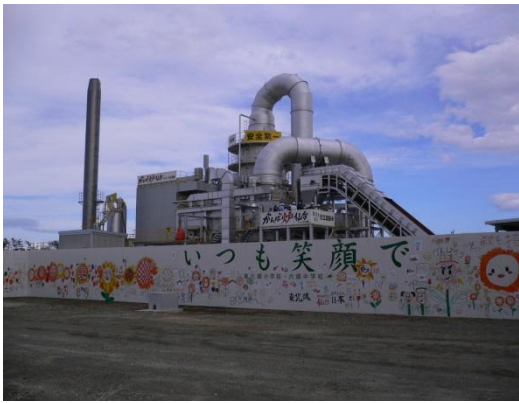
ストーカ炉：仙台市井土搬入場
