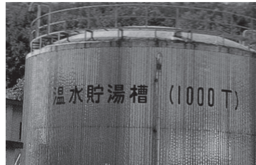
図-4 温泉熱利用による温水(水道水加温)供給の貯湯タンク
