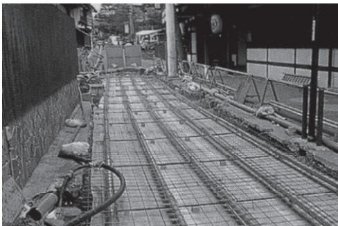
図-3 温泉熱を利用した道路融雪(工事中の道路下埋設配管)
