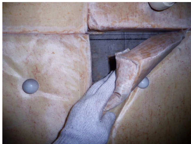
グラスウールの内部を見る
