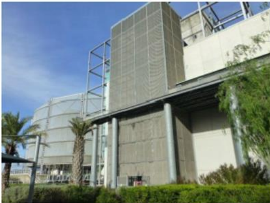
焼却施設(3・4系焼却炉)
