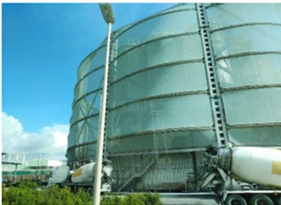
3・4系 排ガス処理設備(シート囲い)
