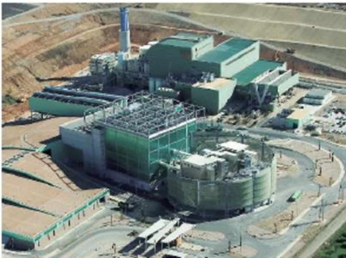
焼却施設(手前:3・4系焼却炉、奥側:1・2系焼却炉)
