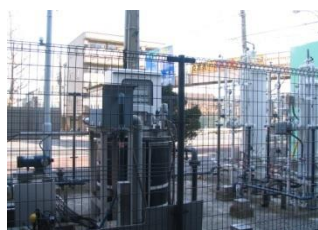
廃水処理施設
