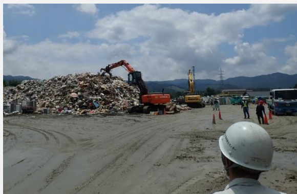
人吉市が設置した仮置場
