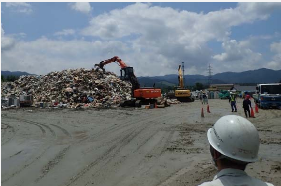
人吉市が設置した仮置場
