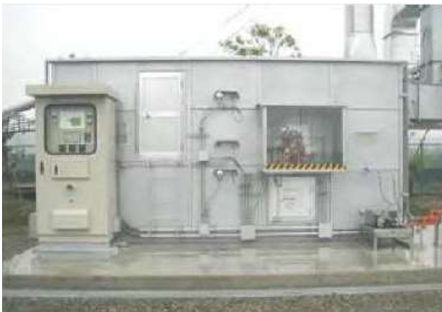
化学品制造企业 橡胶生产设备排放的废气 处理风量：100 Nm 3 /min 处理成分：橡胶生产设备排放的废气 丁二烯
