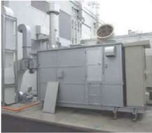
化学品制造企业 涂层机排放的废气 处理风量：30 Nm 3 /min 处理成分：醋酸丁脂、IPA
