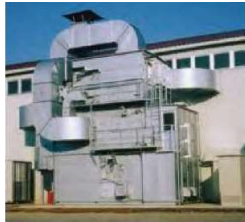
合成树脂制造企业 涂层机排放的废气 处理风量：400 Nm 3 /min 处理成分：在抑制NO x 、N 2 O生成的同时， 处理含有NH 3 和有机氮 (胺、DMF、NMP等) 的废气
