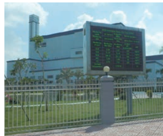
Thoi Lai 地区の発電施設と監視モニタリングパネル
