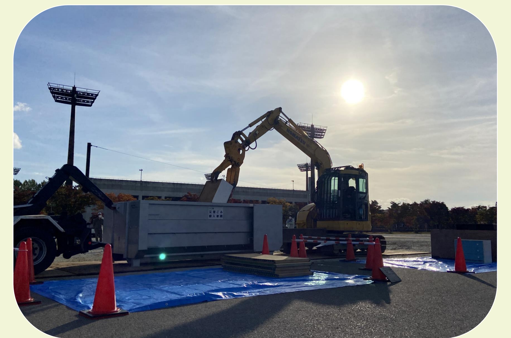
重機を使用した模擬ごみの搬出訓練
