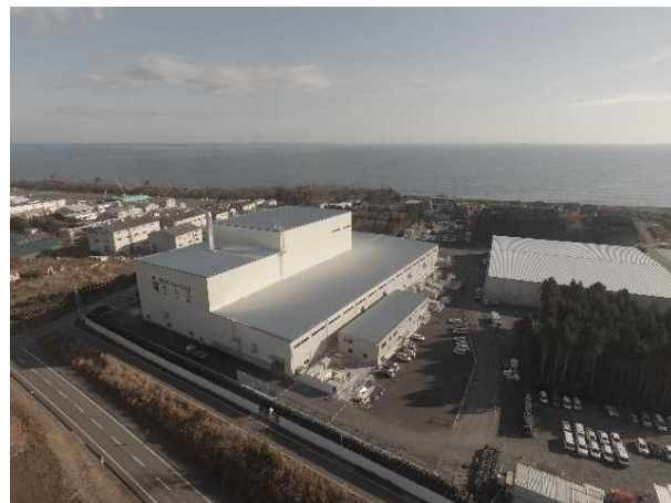
大熊町の仮設焼却施設(平成29年12月)
