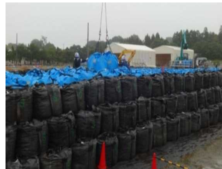
保管場への定置作業
