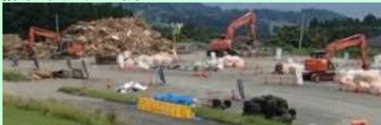
▲二次仮置場の様子
