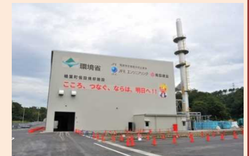
楢葉町の仮設焼却施設 (平成28年10月)
