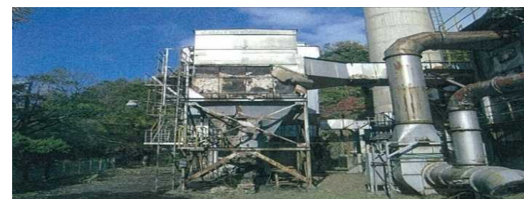
老朽化して休止した処理施設
