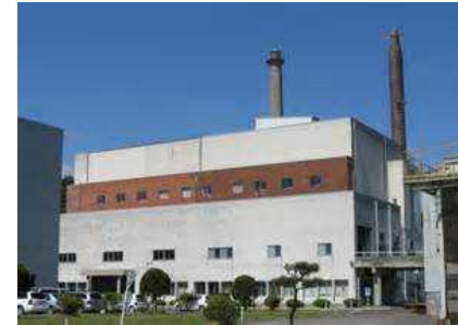
【ごみ焼却施設】
