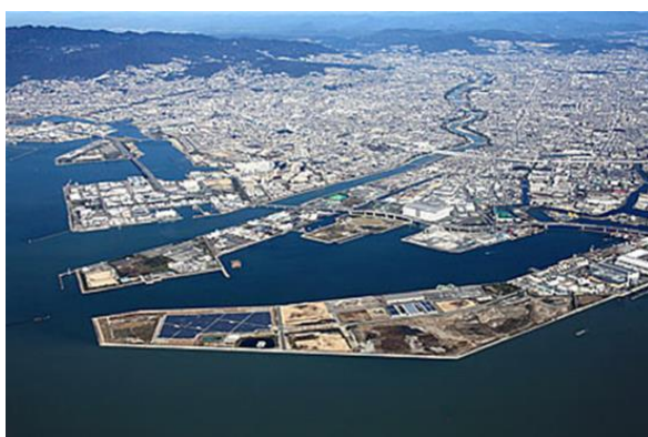
尼崎沖埋立処分場
