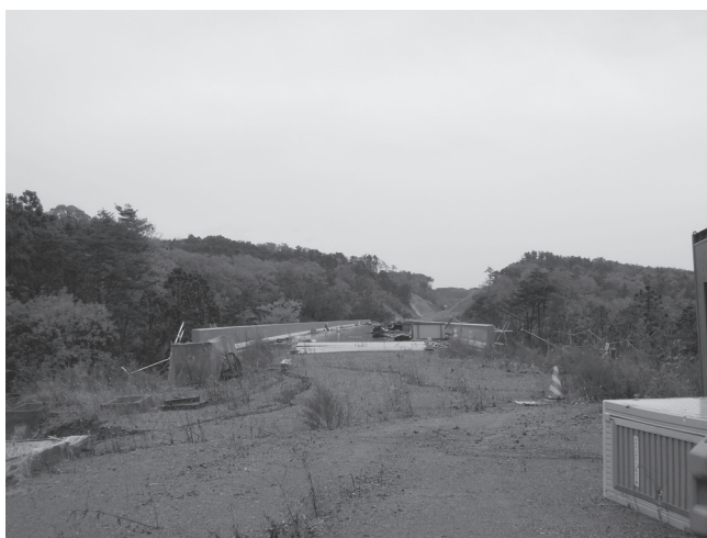
写真10 震災後、工事中の常磐自動車道
