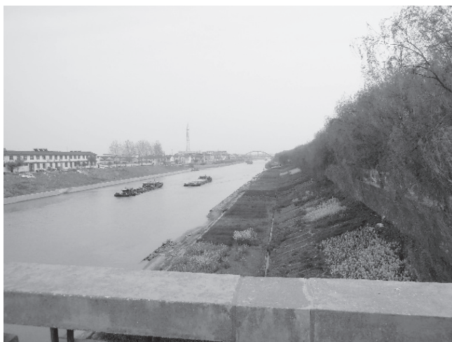
写真11 京杭運河(浙江省鎮江市)。605年隋第2代皇帝が建設
