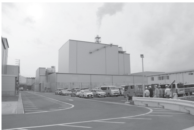
写真11 双葉町にある仮設処理施設
