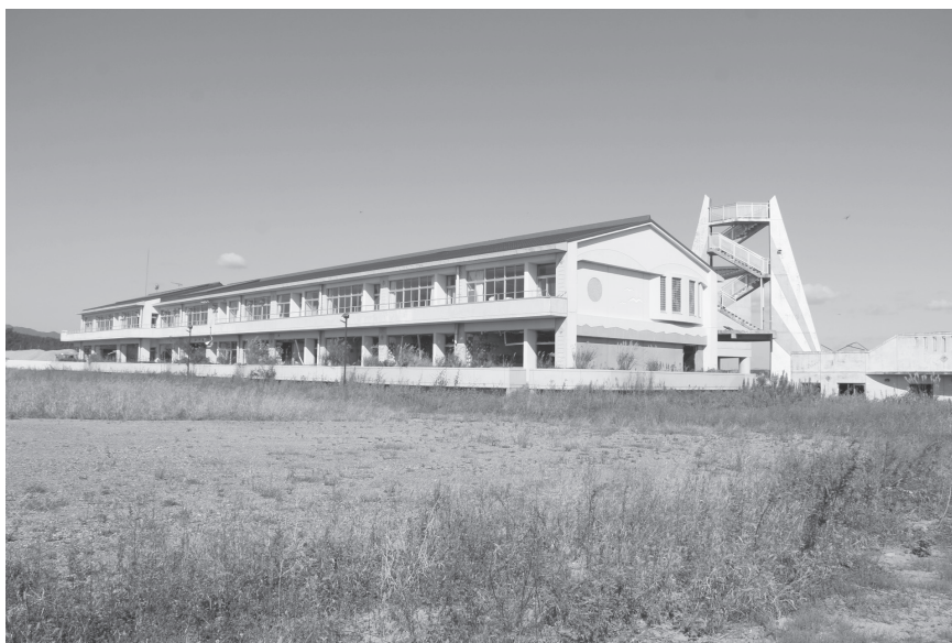
写真13 震災後の請戸小学校 [写真提供：浪江町]
