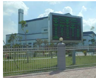
Thoi Lao 地区の廃棄物発電施設とモニタリングパネル
