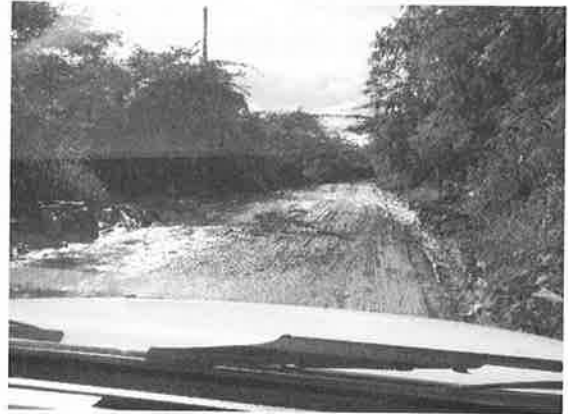
写真3 舗装される前の搬入路(平成20年)
