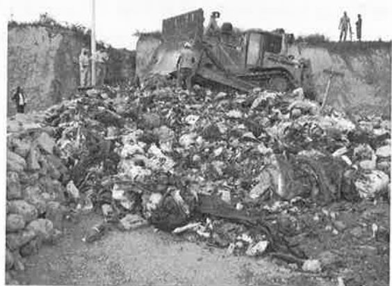
写真5 ごみ初投入時の転圧方法をオンサイトで指導(平成21年)
