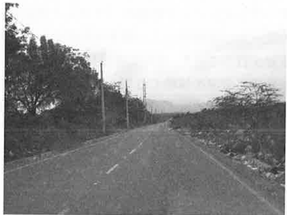
写真4 完全舗装された搬入路(平成23年)
