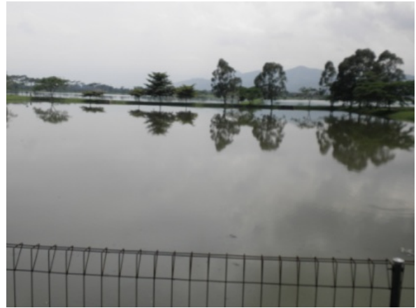
図-2 下水道終末処理施設酸化池全景
