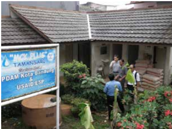
図-1 コミュニティ生活排水処理施設全景
