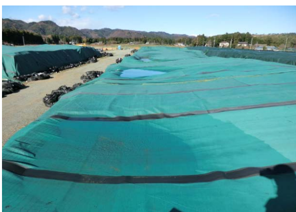
図-5 除染廃棄物等仮置場の様子
