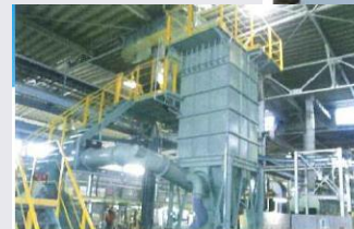
集塵機の製造委託(鞍山本工作所)
