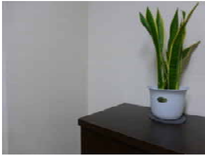
壁 石膏ボード下地にクロス張り
